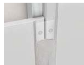
Traitement de joint (Plaques à bords amincis)
